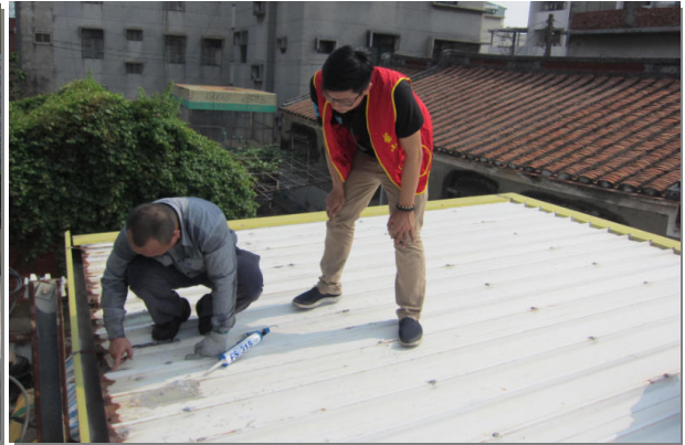
志工協助獨居長輩住家房屋修繕
